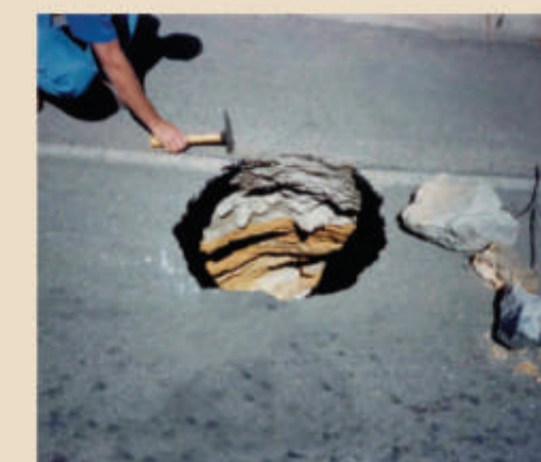
Afundamentos cársticos: aparecimento de buracos e rachaduras em construções.
