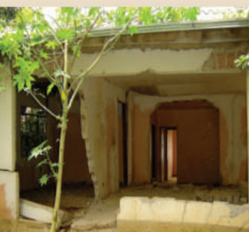
Afundamentos cársticos: aparecimento de buracos e rachaduras em construções.
