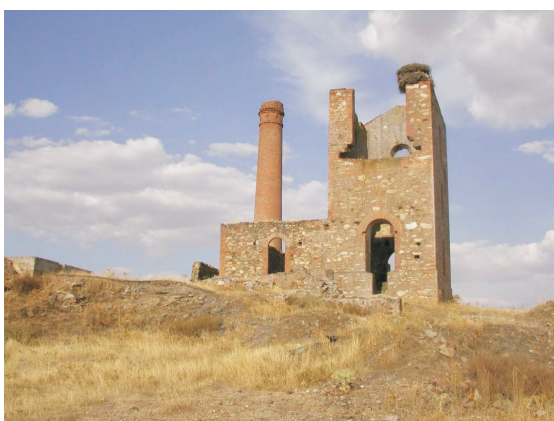
Figura 4 – Casa de máquinas tipo Cornish, mina Santa Catalina, Berlanga (Badajoz, España).
