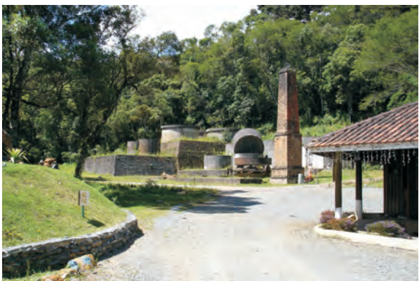
Figura 9 – Ruínas das instalações de beneficiamento, próximas ao CIT
