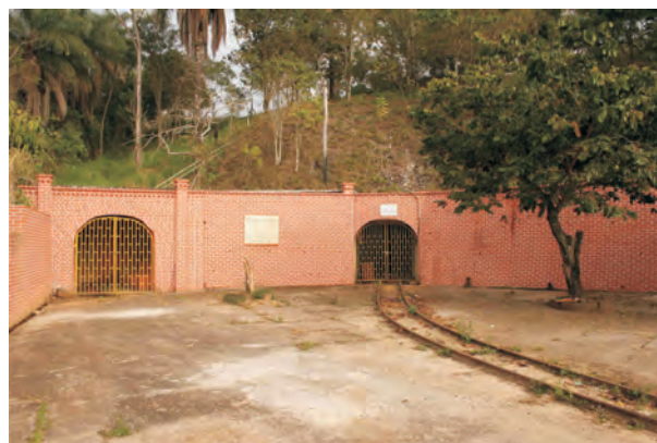
Figura 16 – Entrada da mina de ouro do Faria atualmente desativa em Honório Bicalho. Foto: Úrsula Ruchkys de Azevedo.
