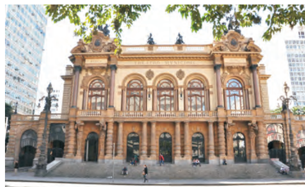
Figura 35 – Teatro Municipal de São Paulo (inaugurado em 1911), fachada frontal em Arenito Itararé e base de Granito Itaquera. Foto: Lauro Kazumi Dehira.
