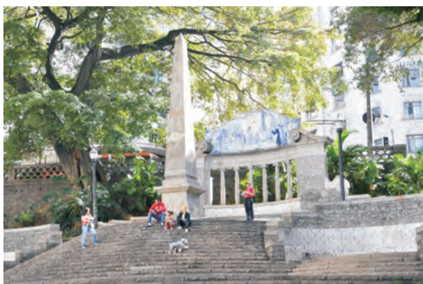
Figura 33 – O monumento mais antigo da cidade de São Paulo – Obelisco da Memória (1814). É constituído pelo Granito Itaquera, e a escadaria implantada no século XX é constituída pelo Granito Cinza Mauá. Foto: Lauro Kazumi Dehira.
