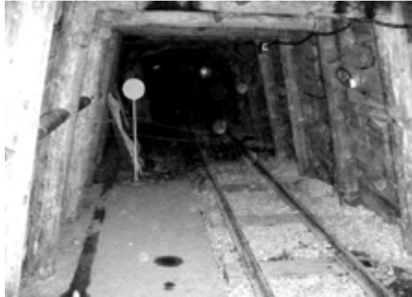
Foto 9. Interior de la Mina de Sant Corneli ( Museu Miner de Cercs, Berguedà )
