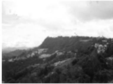
Escarpe de Falla. Ciudad de Manizales
