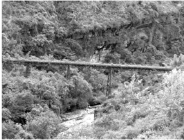
Fotografia 06 - Aqueduto sobre o Ribeirão do Carmo, entre Ouro Preto e Passagem de Mariana (Fotografia de Ronald Peret)
