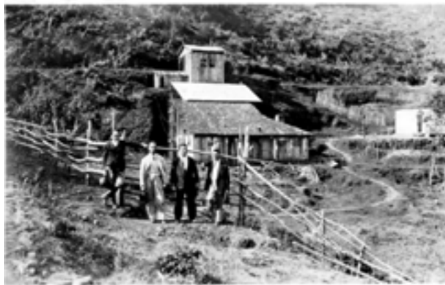
Foto 2 – Vista das instalações de beneficiamento da mina Morro do Ouro. (Acervo Theodoro Knecht, foto tomada por Othon H.Leonardos, sem data.)
