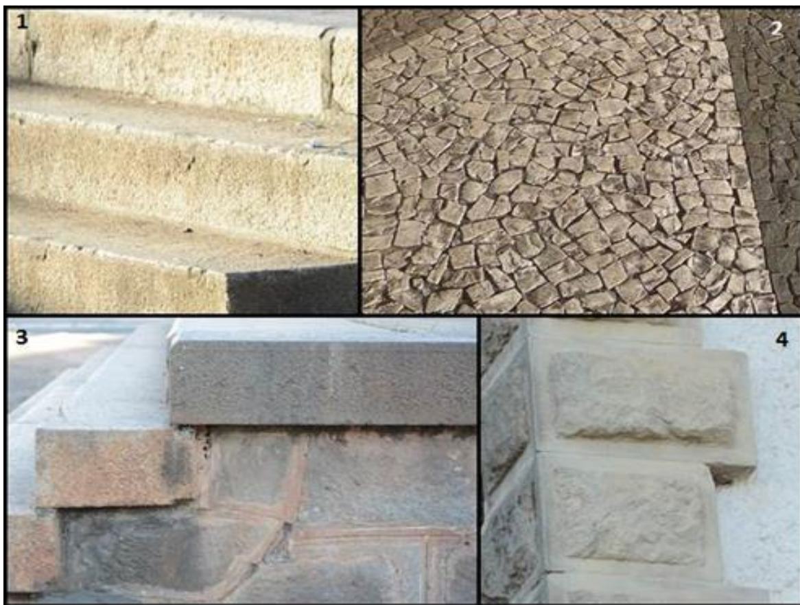
Figura 02 – Imagens das rochas encontradas na constituição do patrimônio do conjunto ferroviário em 2014: 1 - Granito formando a escadaria. 2 - Metacalcário dolomítico em calçada estilo petit-pavé . 3 - Diabásio utilizado na base das estações sob escadas de granito. 4 - Arenito como rocha de sustentação e adorno na construção.
