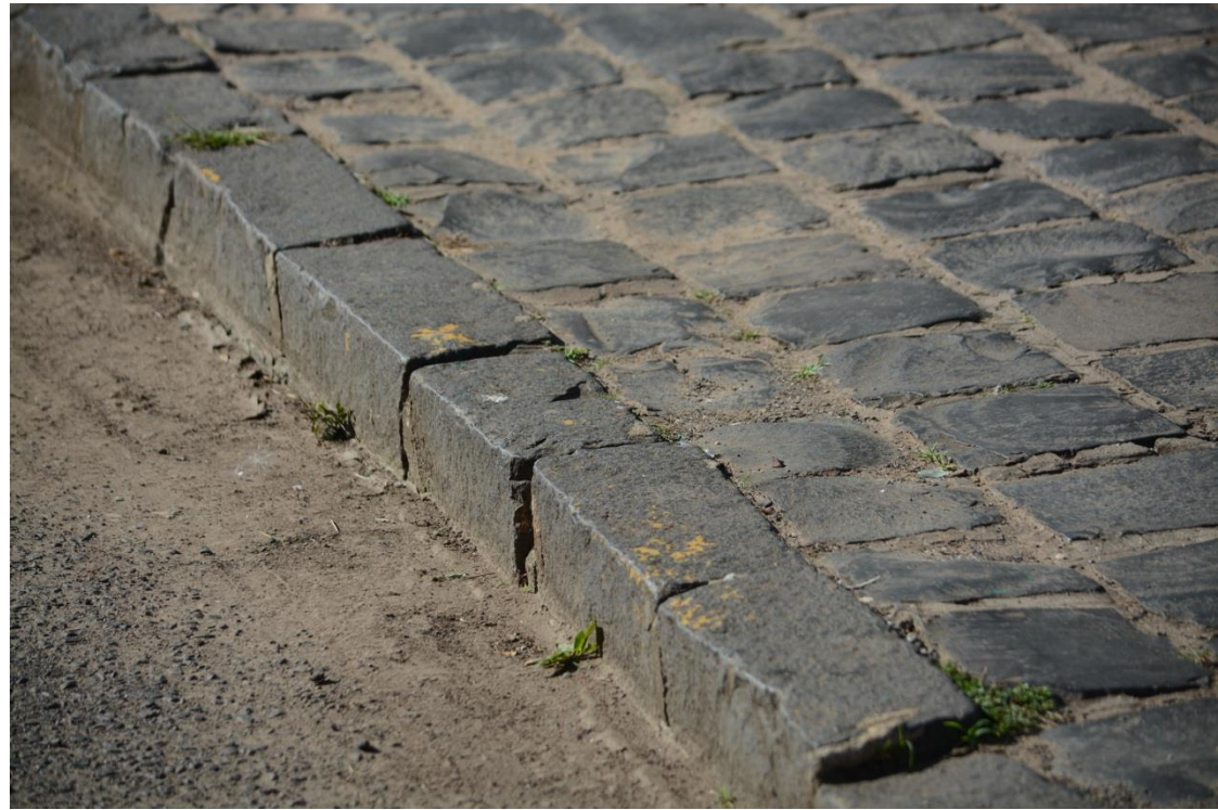
Detalhes de cantarias e pavimentos na estação ferroviária: 1 – Granito; 2 – Lousas e meio fio de diabásio; 3 – Escada de arenito; 4 – Escada de diabásio
