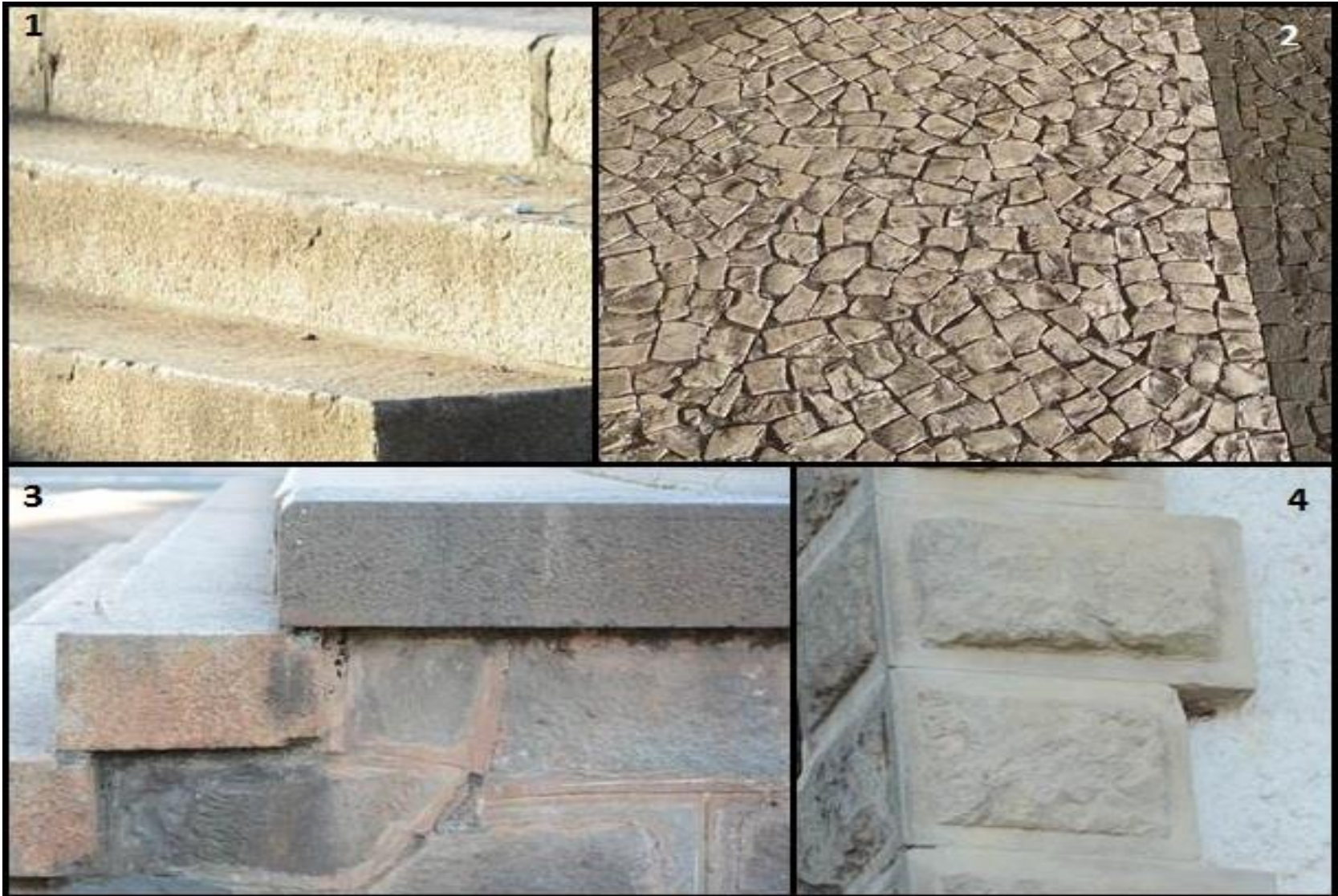
1. Escada de cantaria em diabásio; 2 – Petit pavé de metacalcário dolomítico; 3. Peças de cantaria em granito no terminal de carga de trens; 4. Cunhal da Casa de Memória em arenito. Foto: Alessi
