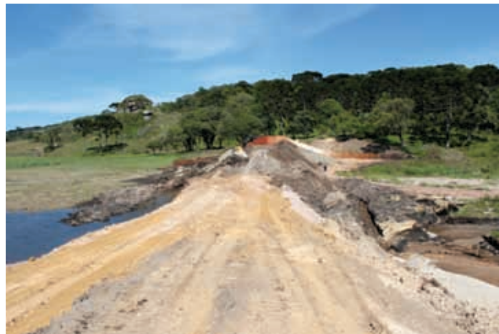
Barramento irregular do Rio Guarituba, no interior do PNCG (notar pessoas como escala).
